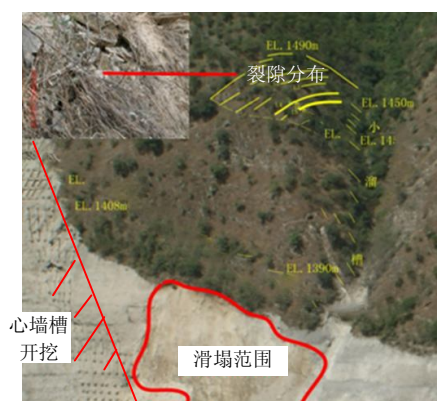
图 2 滑塌及裂缝分布
